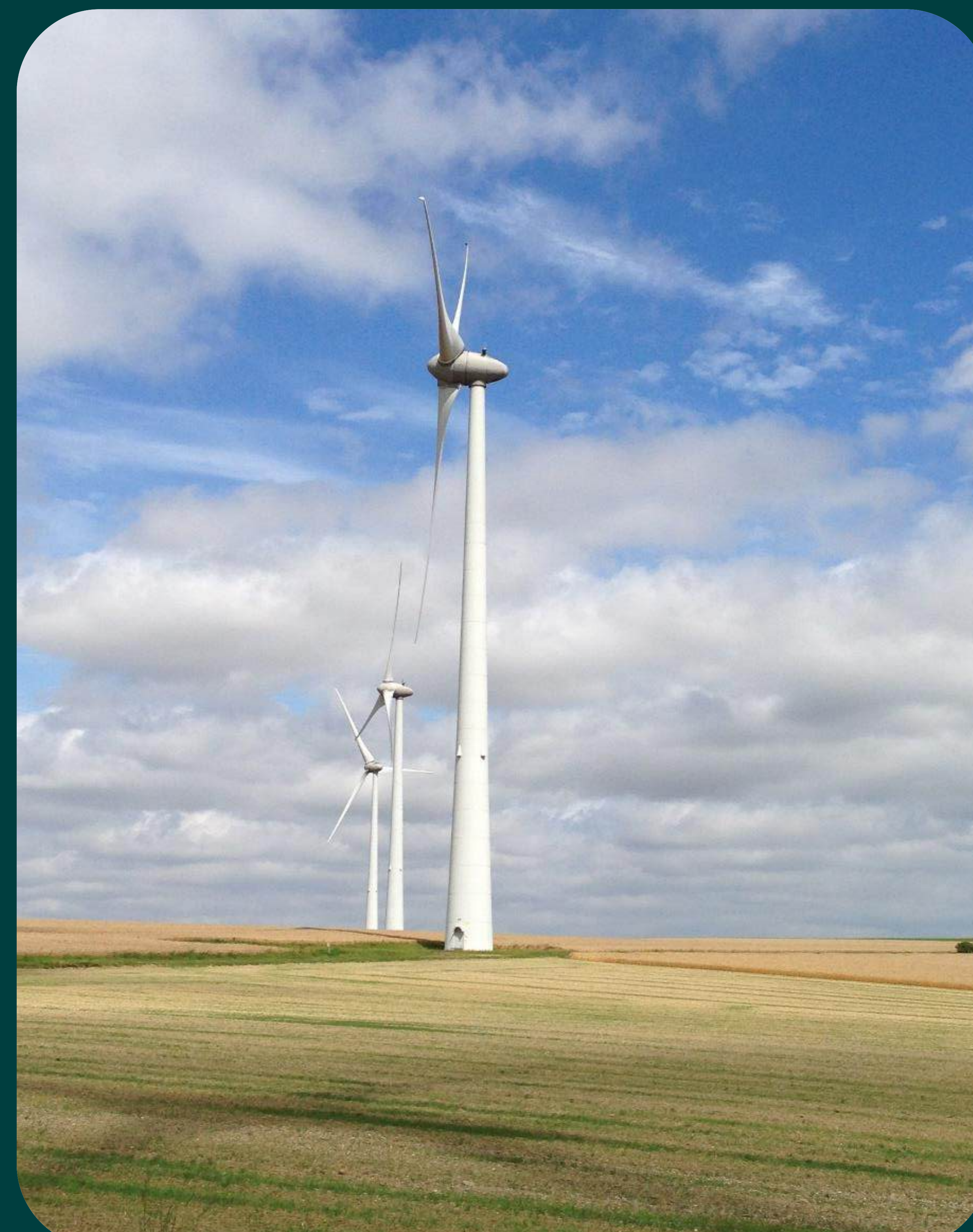
Parc éolien Innergex (France)
