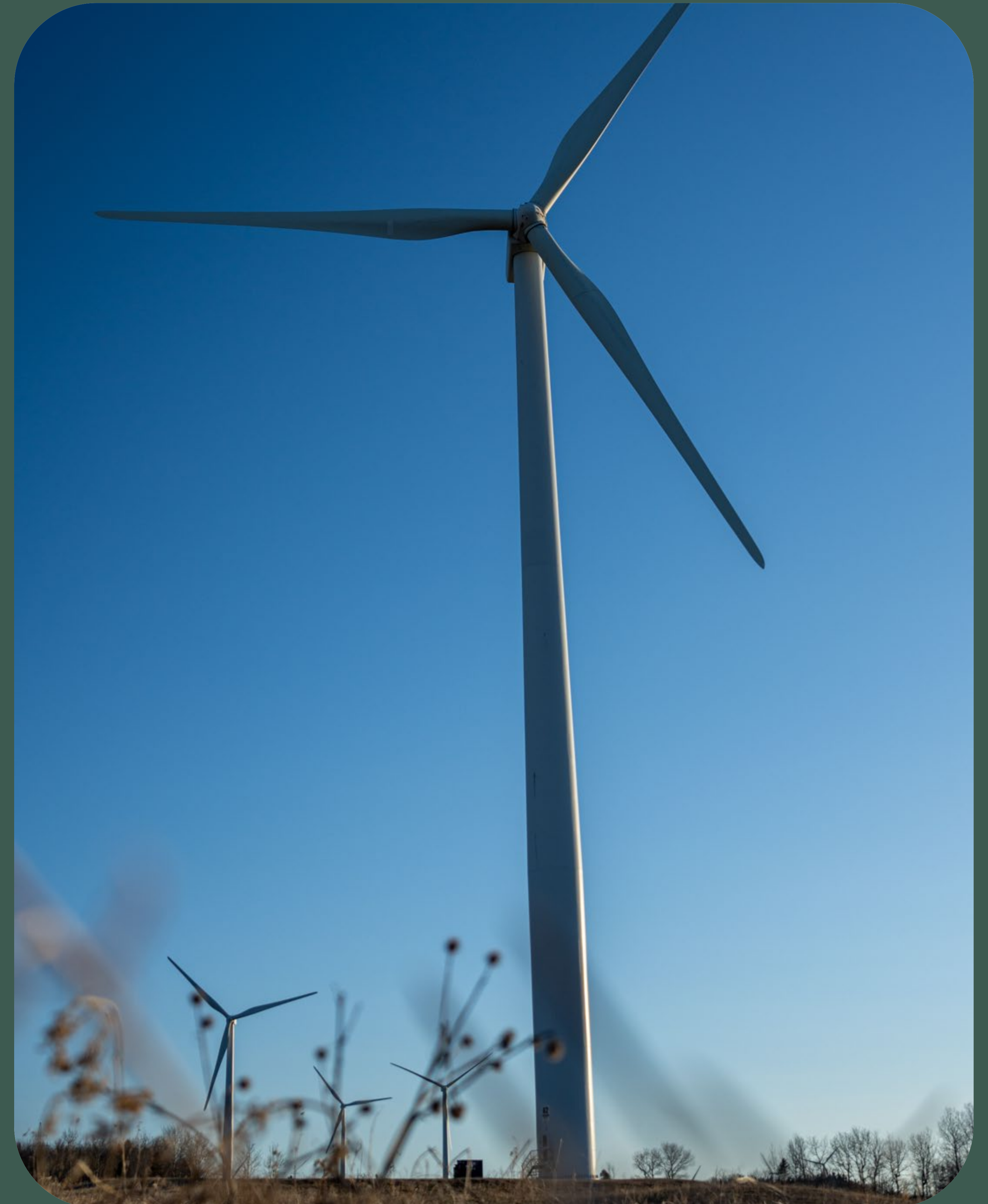
Parc éolien Innergex (Québec)
